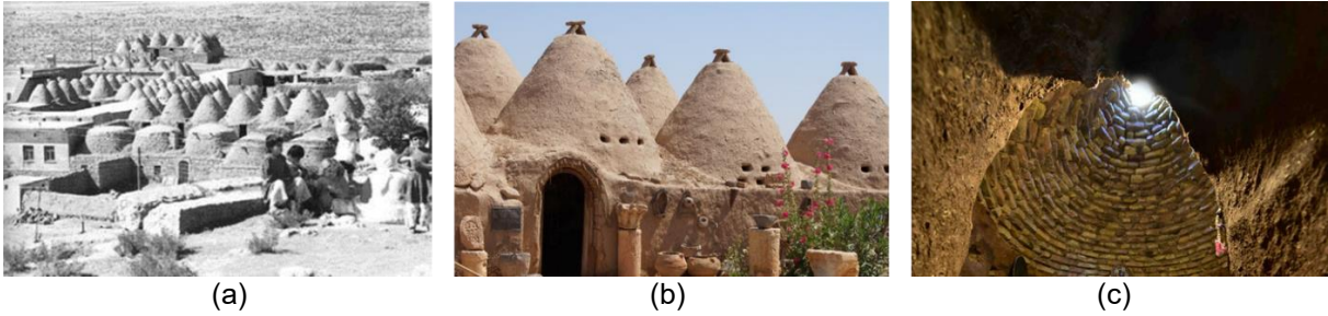
Şekil 7. Harran evleri dış görünüşler ve kubbe egzoz deliği:(a) [78] ; (b,c) [80]
