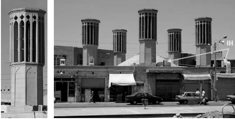
Şekil 27. Sekiz yönlü yelgel uygulaması (Geleneksel yelgelerin yanında, İran'da çok kullanılan mekanik evaporatif soğutmalı ısıl konfor ve havalandırma cihazları-IH görülüyor) [156].
