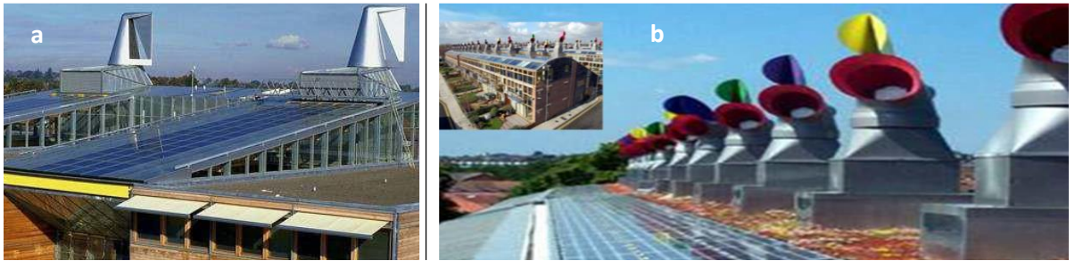
Şekil 16. Modern veya ticari yelgeller: (a) Nottingham Üniversitesi [95]. (b) Güney Londra'da, Beddington Sıfır Enerji Gelişimi Projesi (BedZED Wind Cowl System) [95, 156].
