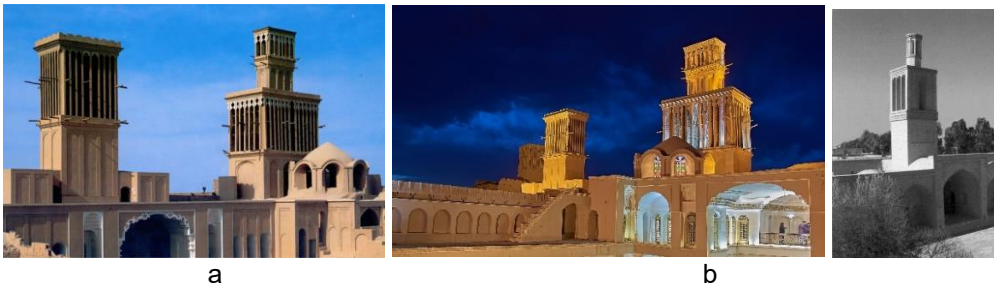
Şekil 30. Özel tasarım çift katlı yelgeller: (a,b) Ağazade evi (Abarkooh, İran), tek katlı ve çift katlı dikdörtgen kesitli yelgeller [121,171]. (c) Kare kesitli ve altıgen kesitli iki yelgelin iki katlı uygulaması [89].
