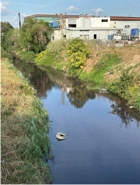
Çerkezköy OSB Giriş
